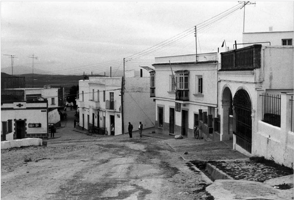
FOTOGRAFÍA 13. Benalup a finales de los sesenta. Se observa la pensión del Coscorrón, el antiguo Ayuntamiento, la Plaza de Abastos... Era la entrada del pueblo, hoy día es parte del casco antiguo.
